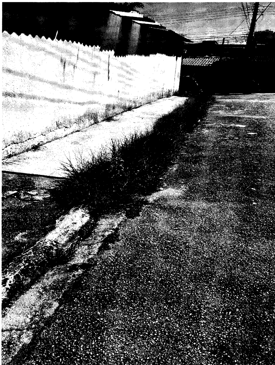
CAPINAÇÃO DE CABEÇAS DE GUIA E RASPAGEM DE SARJETA EM TODA A EXTENSÃO DA TRAVESSA MADEIRAS. VILA CINTRA- MOGI DAS CRUZES.
